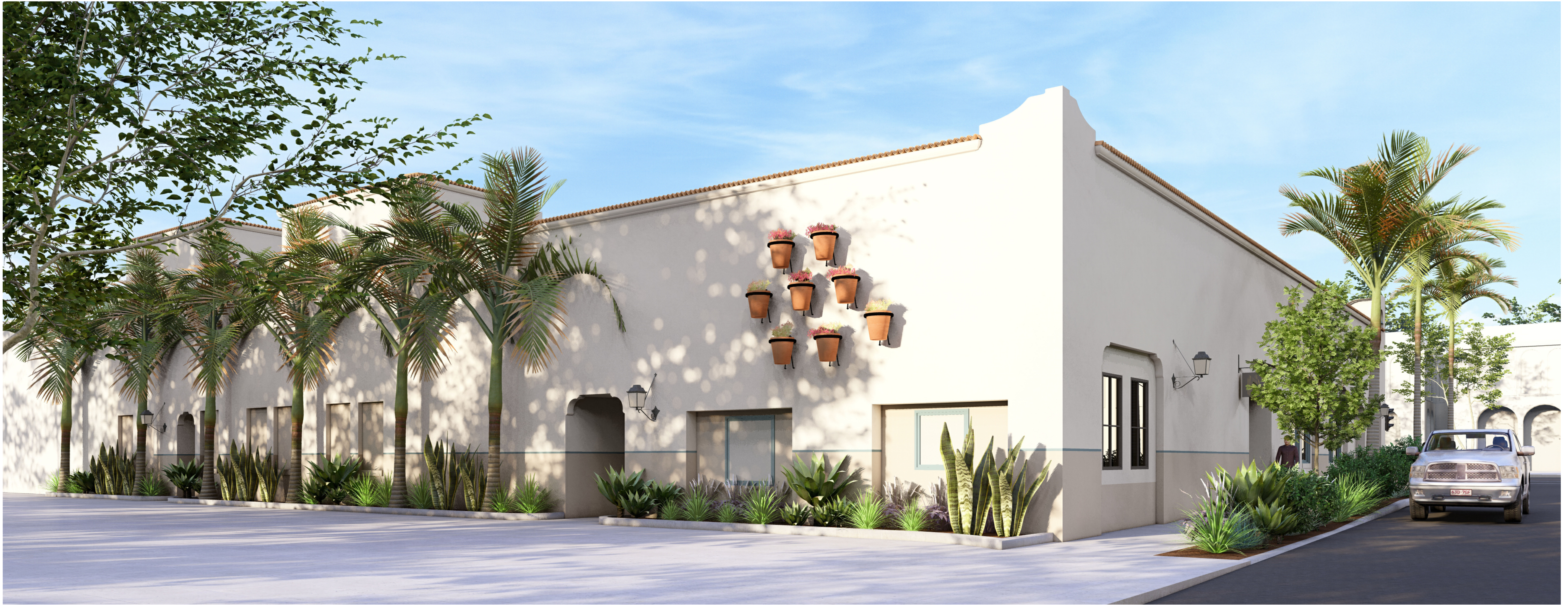
REAR VIEW - SOUTH PASEO DE LAS GRANADAS
