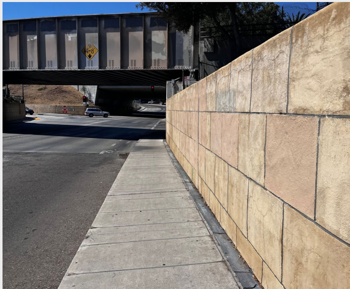
Castillo Street (Existing/ Actual )
