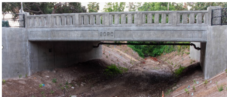
Sustitución del puente de la calle Quinientos, finalizada en 2020
