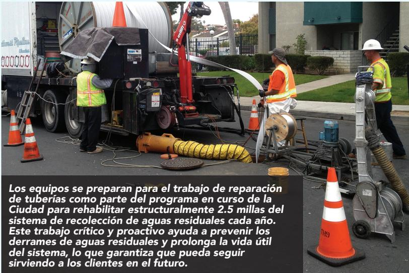
Los equipos se preparan para el trabajo de reparación de tuberías como parte del programa en curso de la Ciudad para rehabilitar estructuralmente 2.5 millas del sistema de recolección de aguas residuales cada año. Este trabajo crítico y proactivo ayuda a prevenir los derrames de aguas residuales y prolonga la vida útil del sistema, lo que garantiza que pueda seguir sirviendo a los clientes en el futuro.
